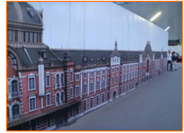
↑東京車站修建中 重新拉皮與結構補強
